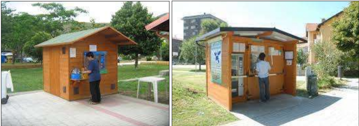
Figura 3 - Esempi di Casa dell'acqua
